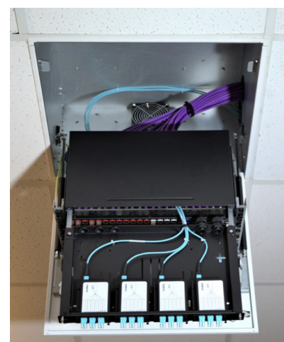
Obudowa z zainstalowanymi ModLink MTP/MPO
