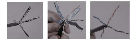
**CAUTION:** THE MOLEX C6A CABLE SHOWN HERE IS <u>UNSHIELDED</u>. IT DOES NOT INCLUDE A DRAIN WIRE OR BRAID. THE FOILS PROVIDE ANEXT PROTECTION. DO NOT CONNECT ANY OF THE FOILS TO GROUND. THIS CABLE <u>DOES</u> <u>NOT REQUIRE GROUNDING OR BONDING</u>
